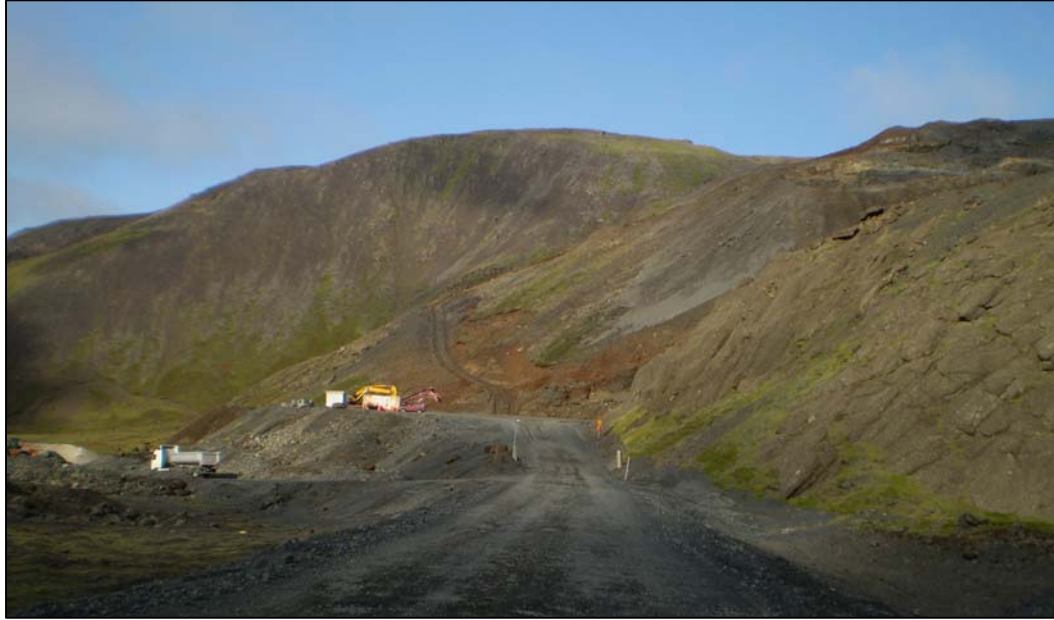
Mynd 1.2 Núverandi efnistökusvæði í Lambafelli, séð frá aðkomuvegi austan við. Hægra megin sést nær ósnortin suðausturhlíð fjallsins, haftið (ljósmynd Mannvit hf., sept. 2008).
